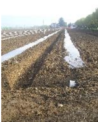
Canali di infiltrazione
