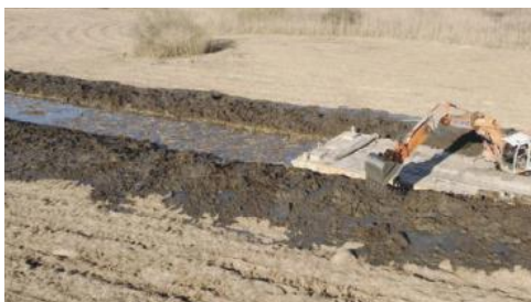
Pulizia dei canali con asportazione dei sedimenti
