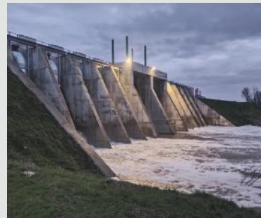
Impianto idrovoro delle Acque Alte a Sermide, loc. Moglia
